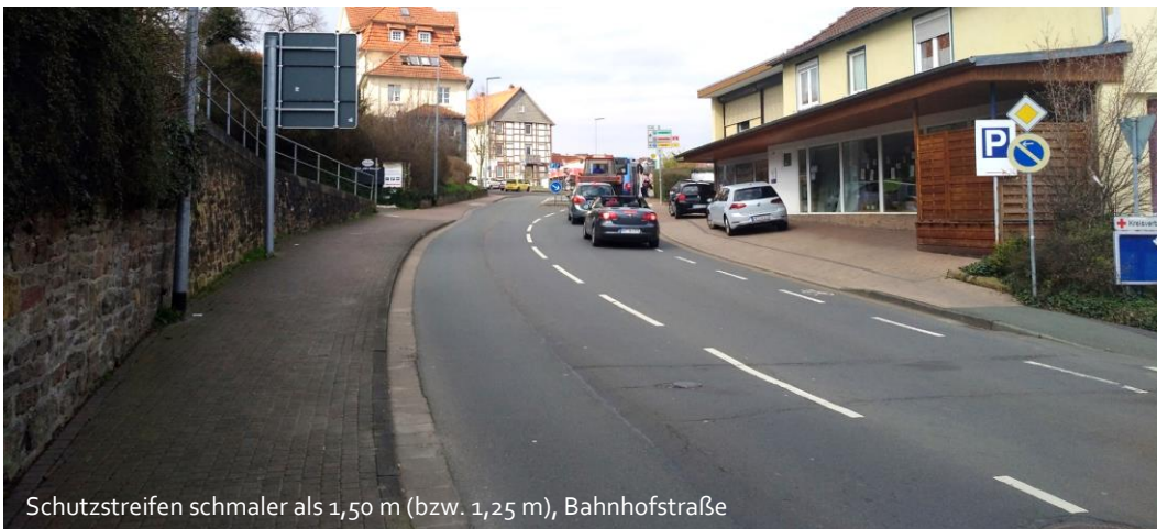
Abbildung 21: Mangelhafte Breiten von Schutzstreifen
