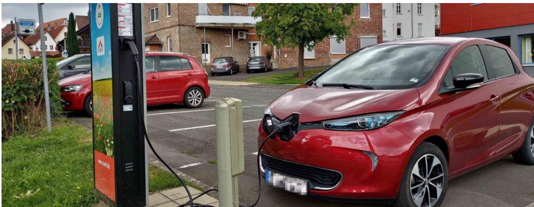
Abbildung 29: Kfz-Ladestation in der alten Friedhofsstraße)
