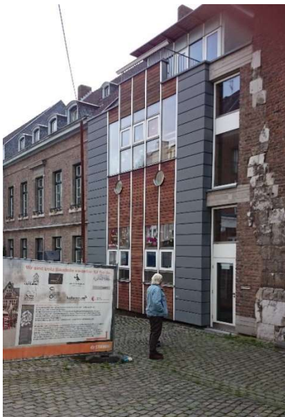
Baulückenschluss in Aachen
